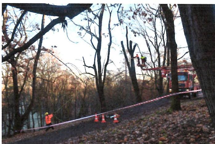
**Postupné kácení větví tvořících primární korunu – s přetažením lanem v požadovaném směru**
