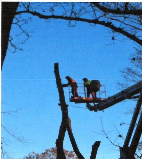
**Postupné kácení větví tvořících primární korunu – bez přetažení lanem**
