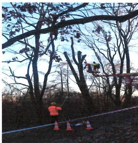
**Postupné kácení větví tvořících primární korunu – s přetažením lanem v požadovaném směru**
