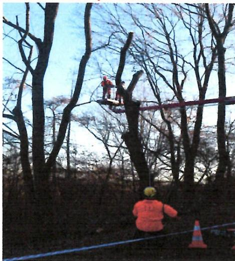
**Úklid větví před kácením kmene - důvodem je bezpečnost práce, dřevorubec má volný pohyb při kácení stromu neomezený popadanými větvemi a má rovněž možnost bezproblémového naplánování únikové trasy, při případném a nečekaném pádu káceného stromu**
